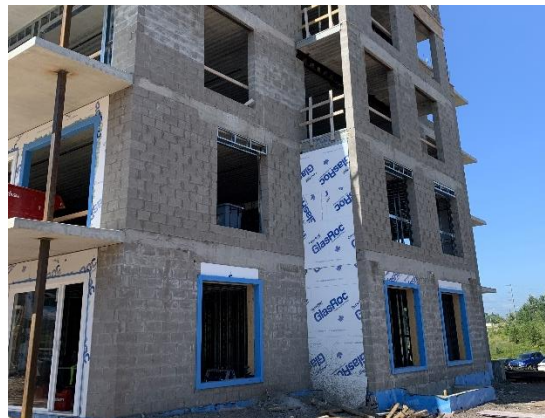
Figure 1: Immeuble en maçonnerie porteuse en cours de construction
